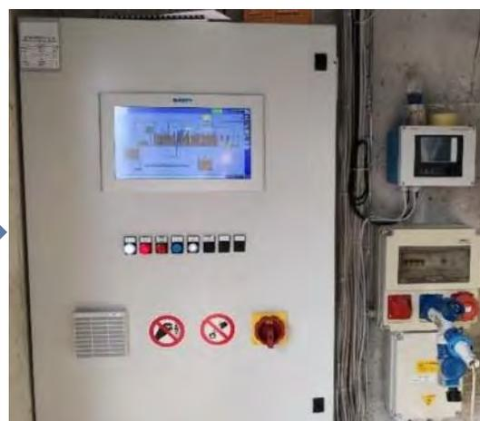
*Nuovo quadro fornito da AgriDep con telecontrollo SCADA.*
