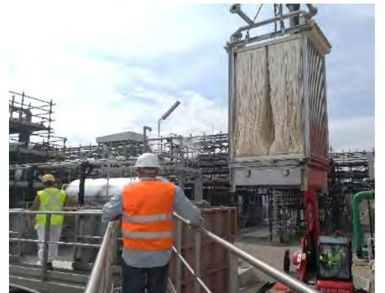
Fango molto viscoso, con inglobamento della biomassa delle fibre. Spesso, in questi casi, occorre estrarre i moduli a membrana ed effettuare la manutenzione e pulizia meccanica.
